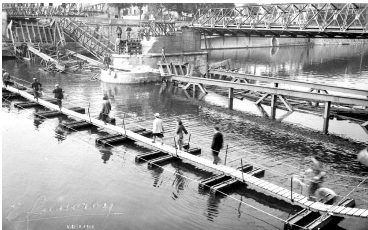
Passerelle provisoire établie sur le bras sud de la Seine pendant la Seconde guerre mondiale. Photographie. (AM Melun. 3 Fi 17)
