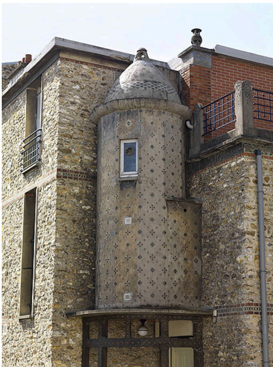
Détail de la tourelle d'angle.
