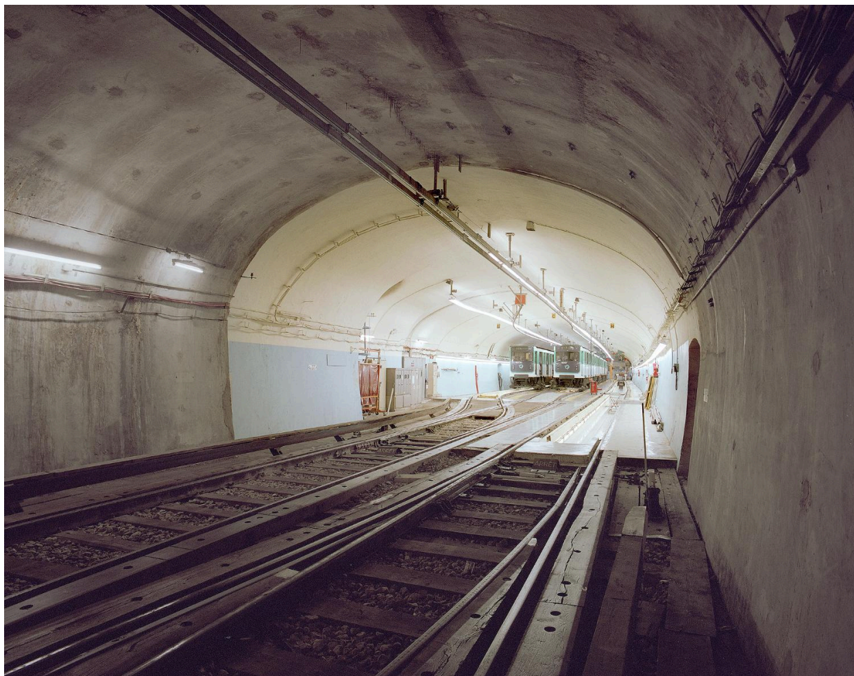
Entrée de l'atelier, depuis le raccordement ligne 11.
