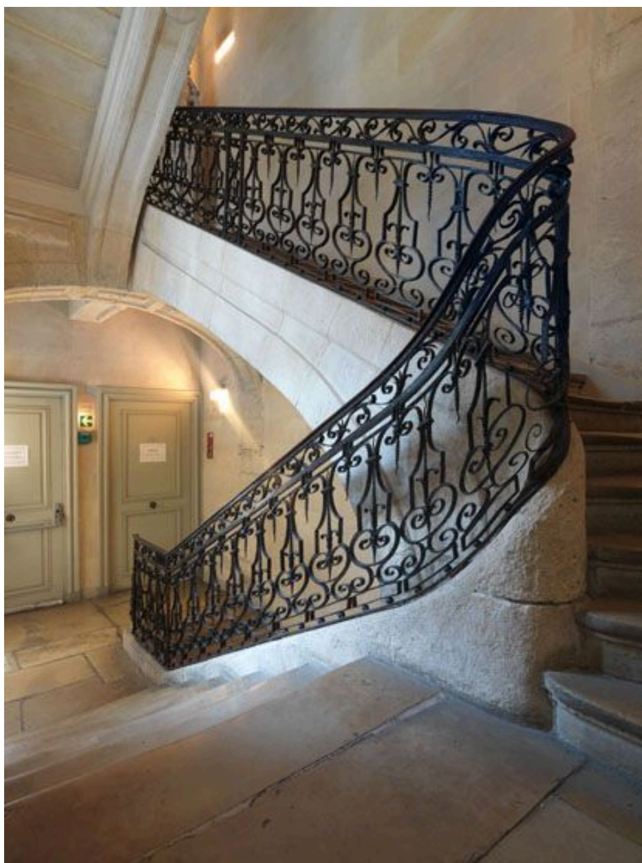
Vue d'ensemble des deux premières volées.
