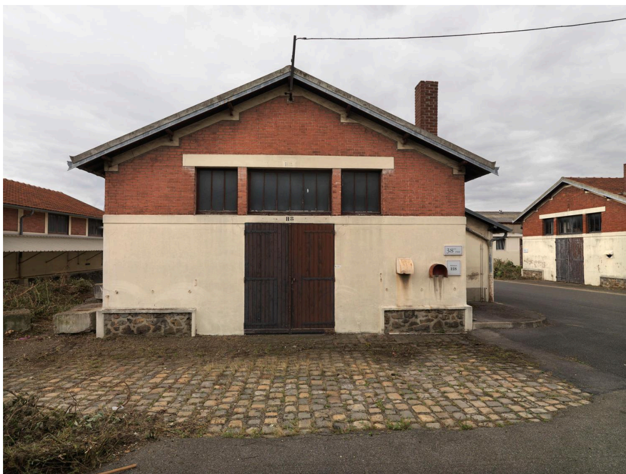
Site Biocitech. Vue des écuries désaffectées.
