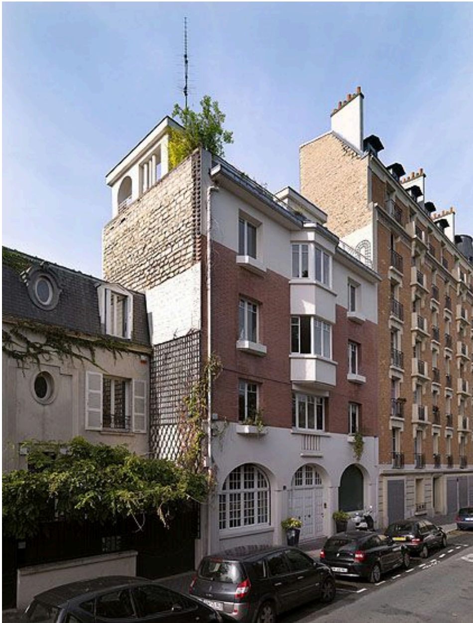
92, Boulogne-Billancourt, immeuble, 3 bis avenue Jean-Baptiste-Clément . Façade antérieure de l'immeuble sur l'avenue Jean-Baptiste-Clément.
