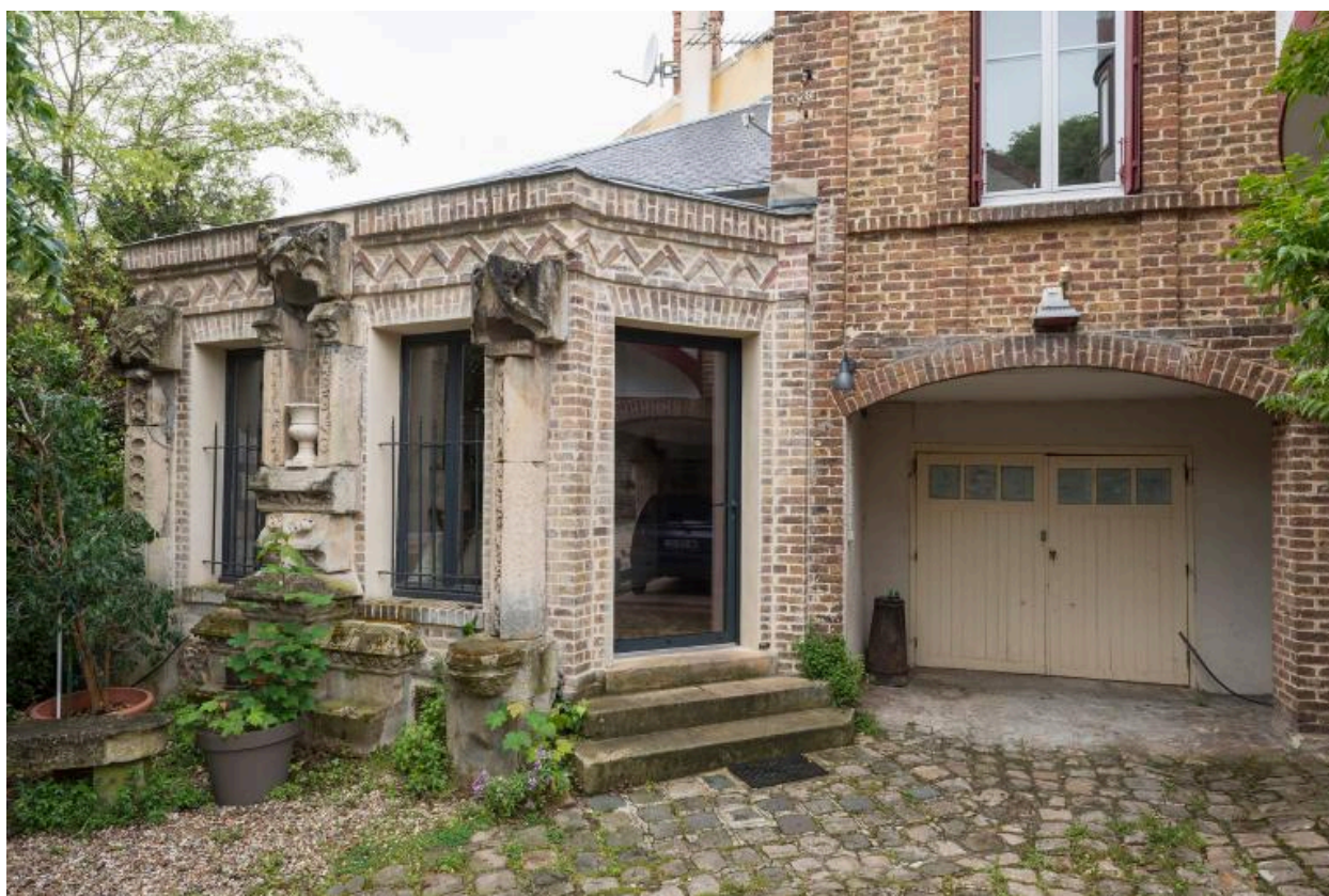
Détail du bâtiment accolé à l'atelier
