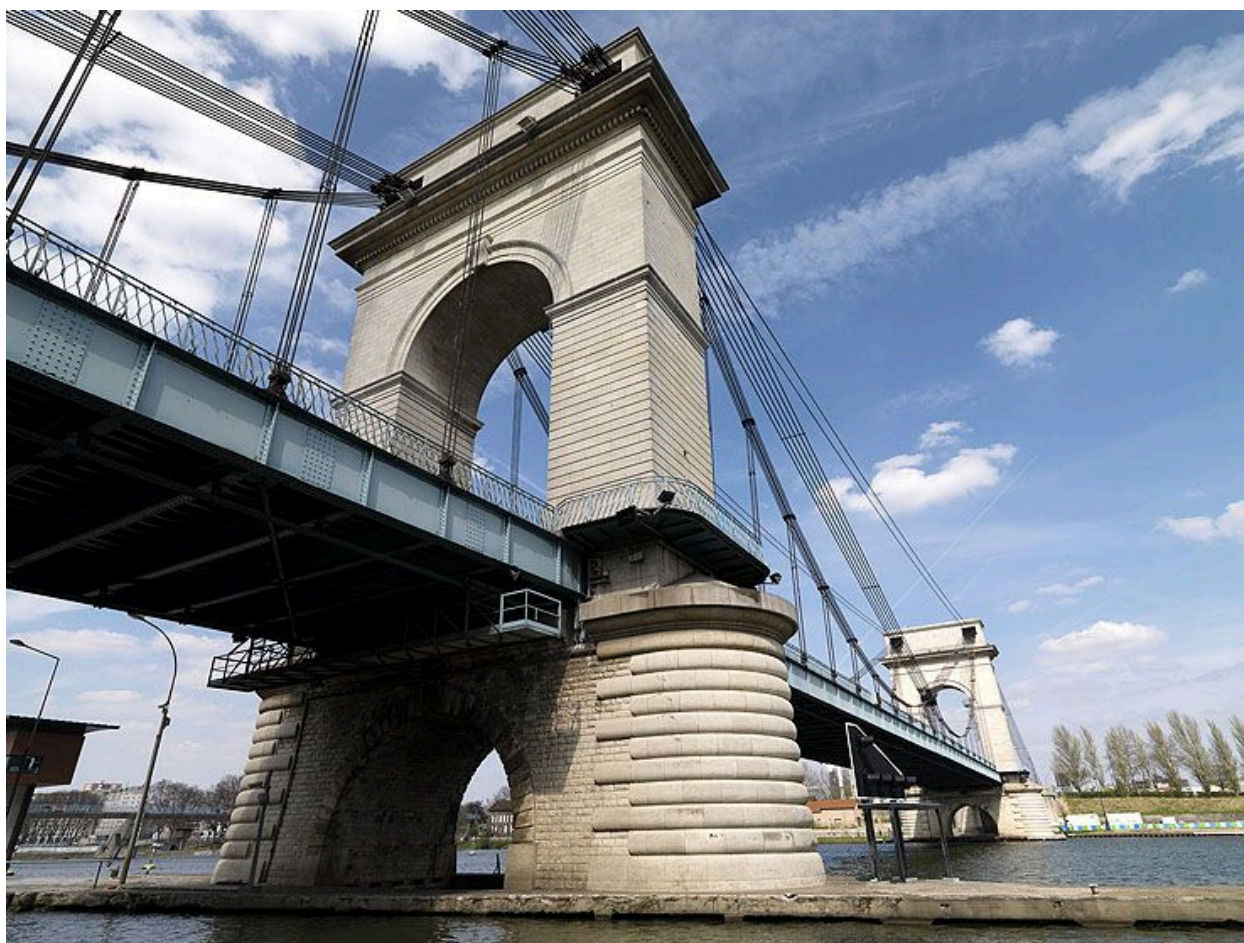
Vitry-sur-Seine, Alfortville. Pont de Port-à-l'Anglais. Vue d'ensemble depuis la rive de Vitry.
