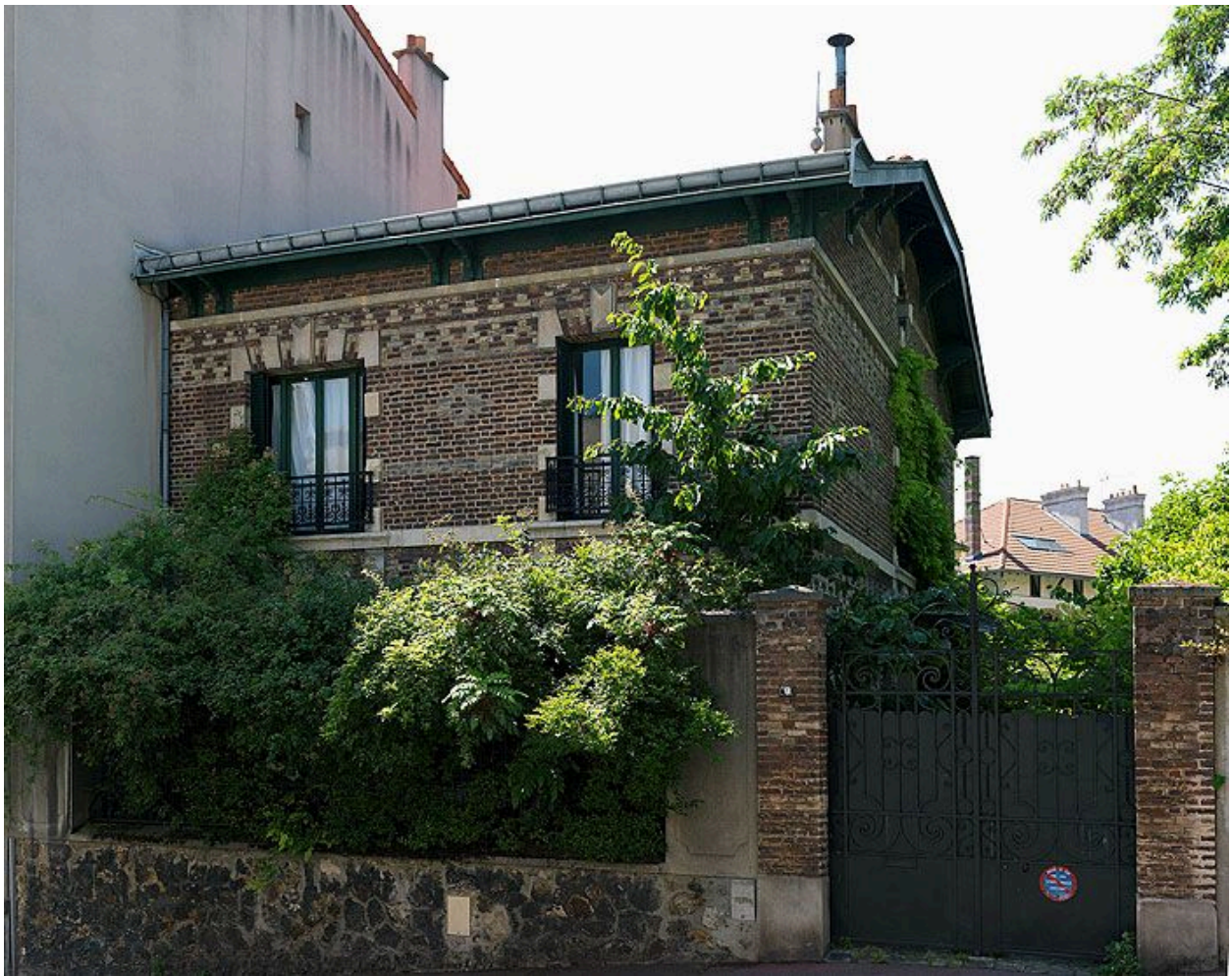
94, Gentilly, maison, 9 rue de la Poste. Façade antérieure de la maison.
