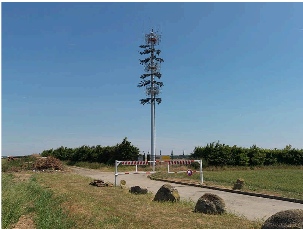
95, Bonneuil-en-France, rue du Pont Yblon. Vue générale avec antenne relais.
