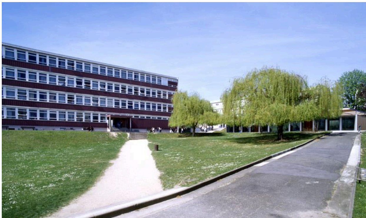
Lycée général Louise Michel, rue Benjamin Moloïse. Heulot, Julien (architecte communal). Vue des bâtiments depuis la vaste pelouse.
