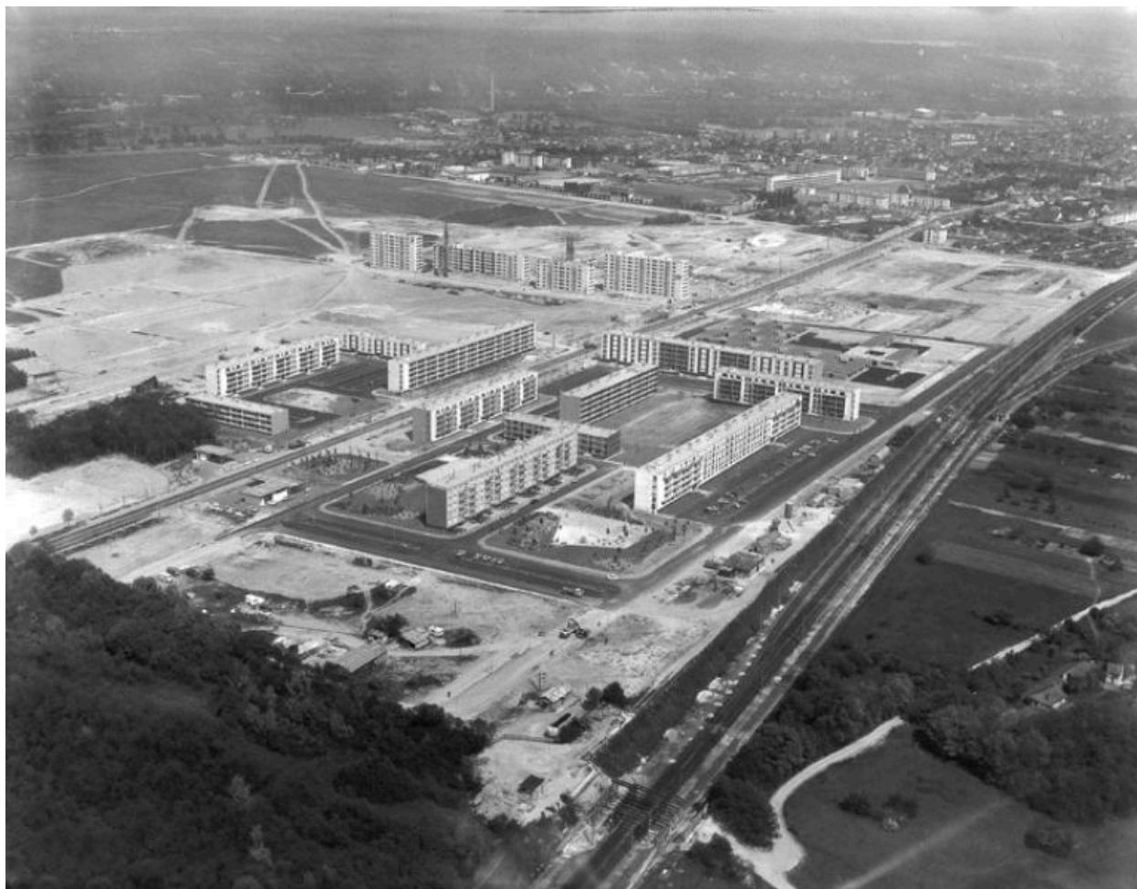
Vue aérienne vers l'est des secteurs 2 et 1 en construction. (Fonds Bertin).
