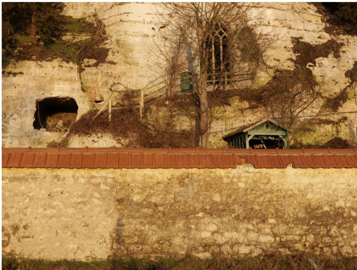
Bennecourt : boves remarquables le long de la D 100.
