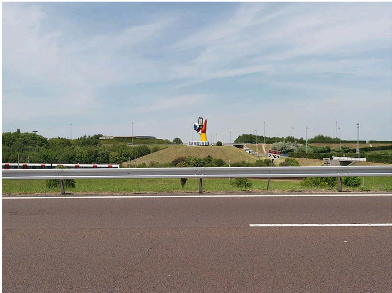
95, Roissy-en-France. Publicité au milieu du réseau routier de la plateforme aéroportuaire.
