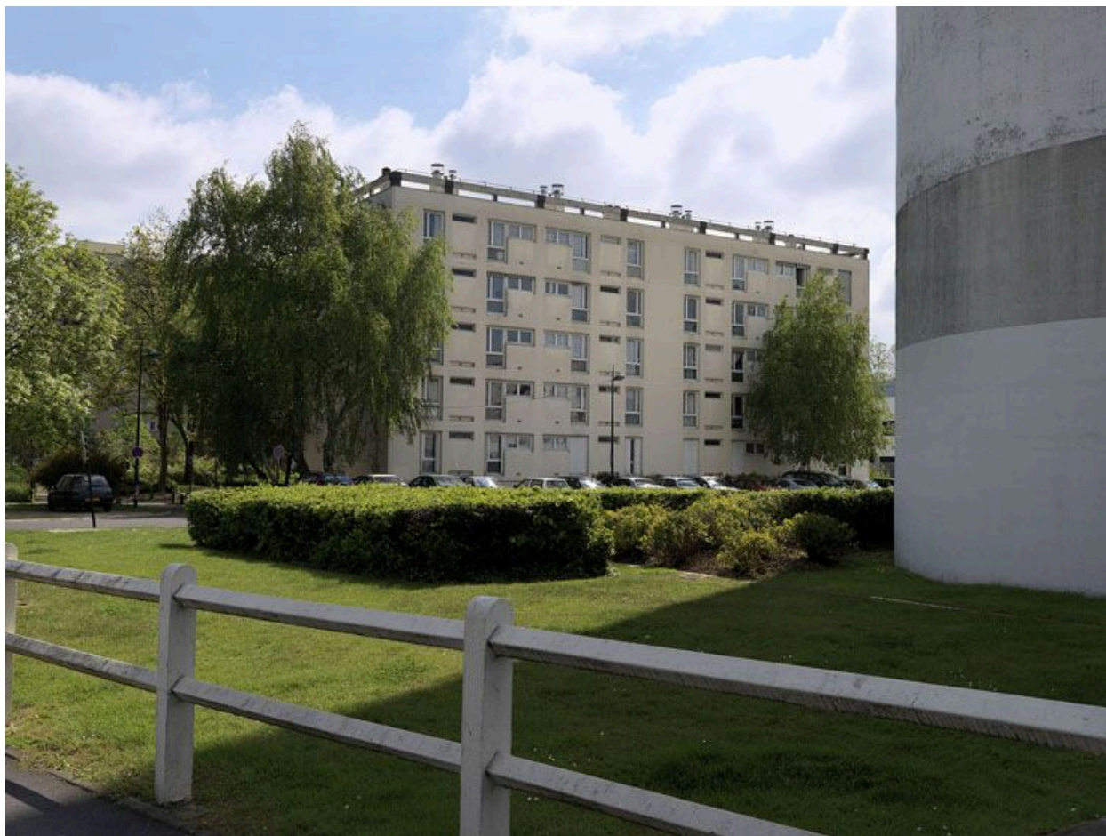
Façade arrière de la barre C.
