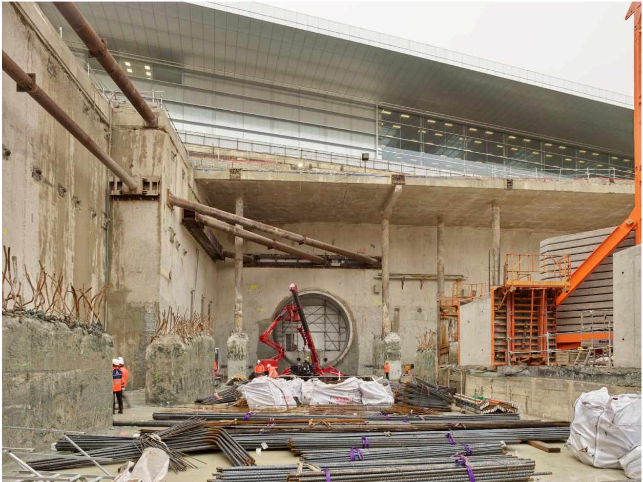
16/12/2020, chantier de construction de la station de métro Aéroport d'Orly (lignes 14 et 18) vu depuis le nord.
