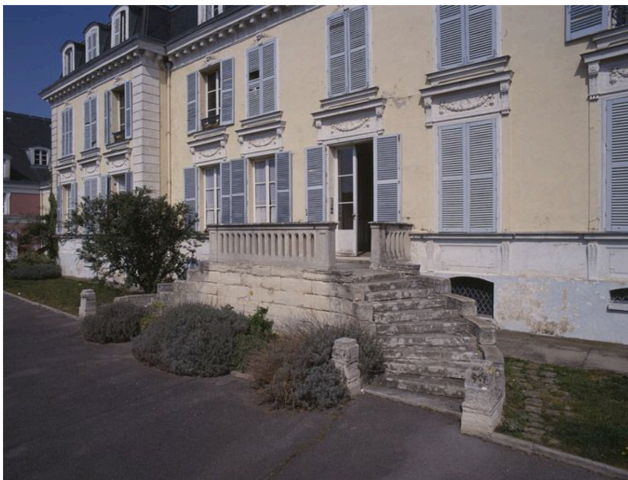
Escalier en fer à cheval situé devant la façade principale.
