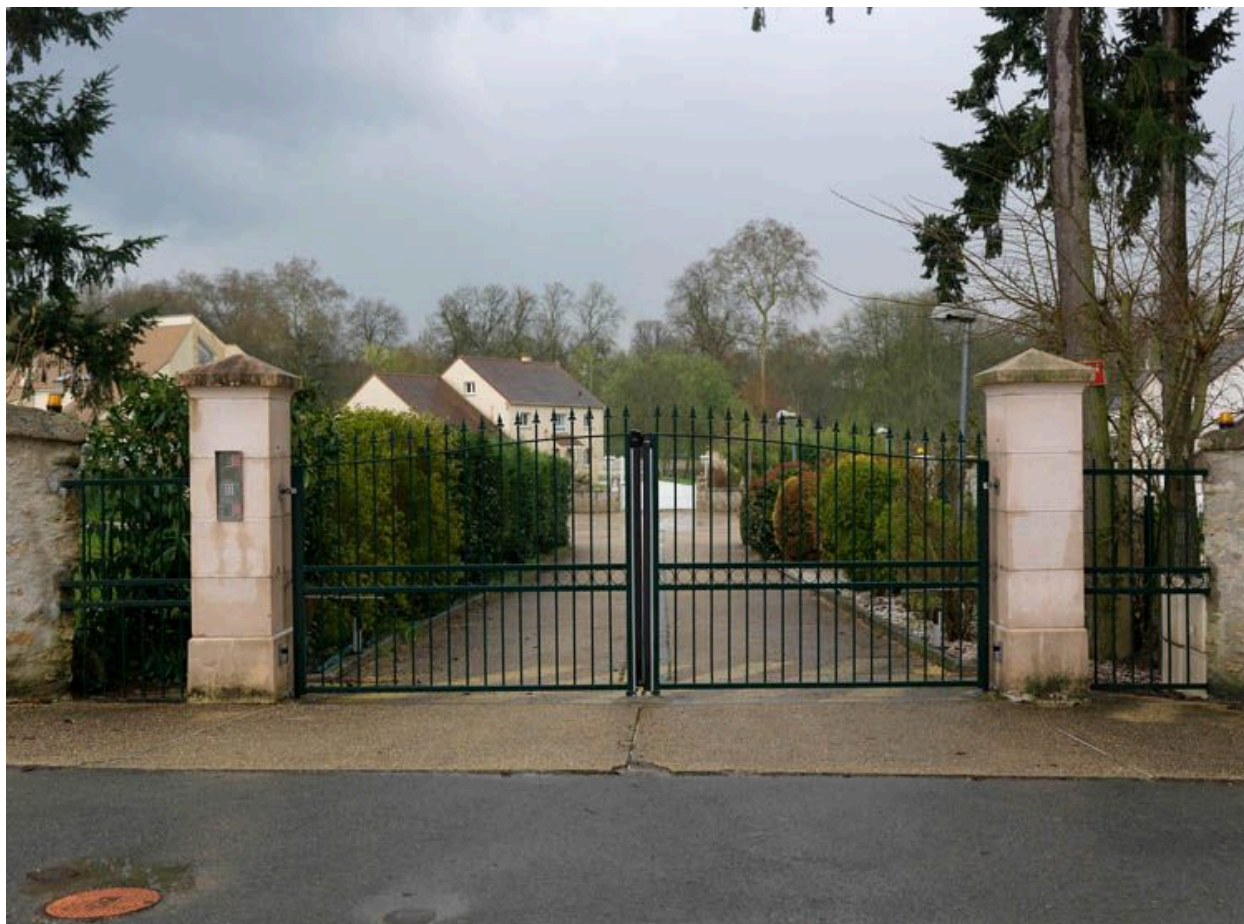
Saint-Chéron. Vue du portail d'entrée du lotissement de la Chaumette.
