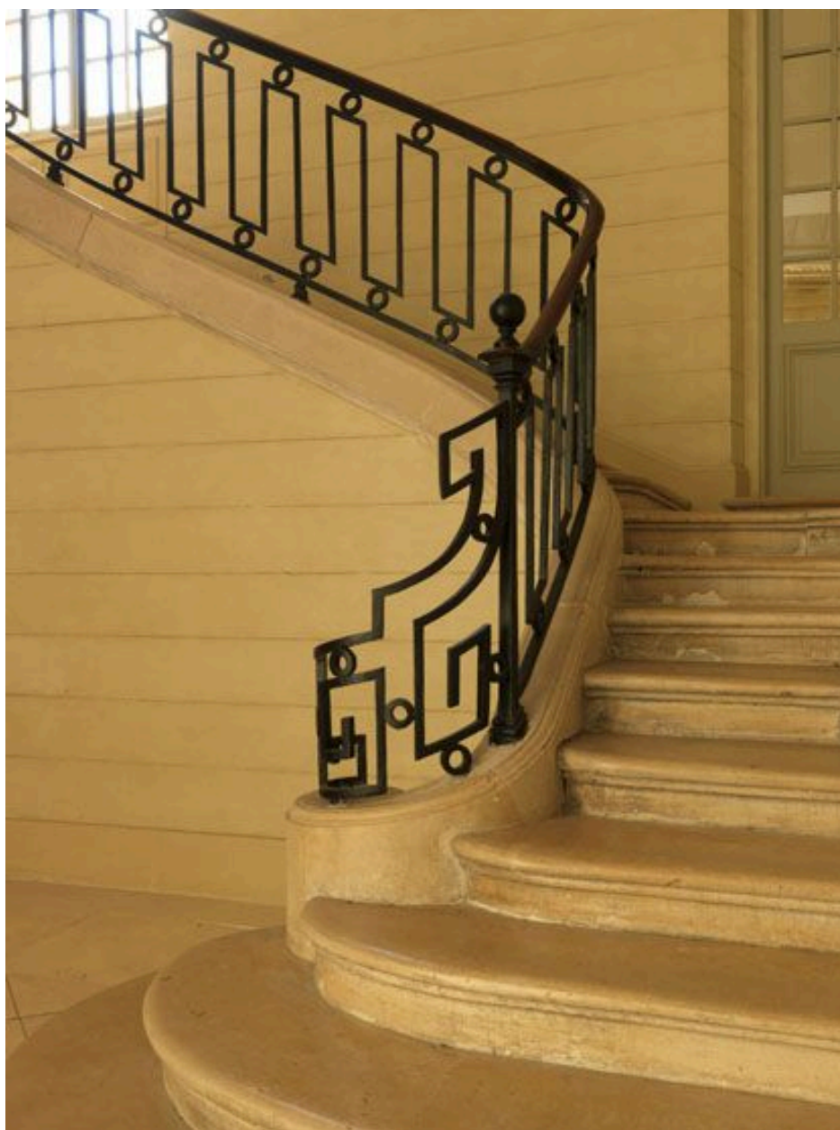
Vue de la console à la grecque du départ de l'escalier, 14 rue Saint-Guillaume.
