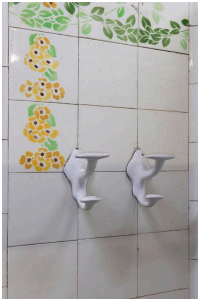
Détail de deux patères, dans une cabine de bain-douche.
