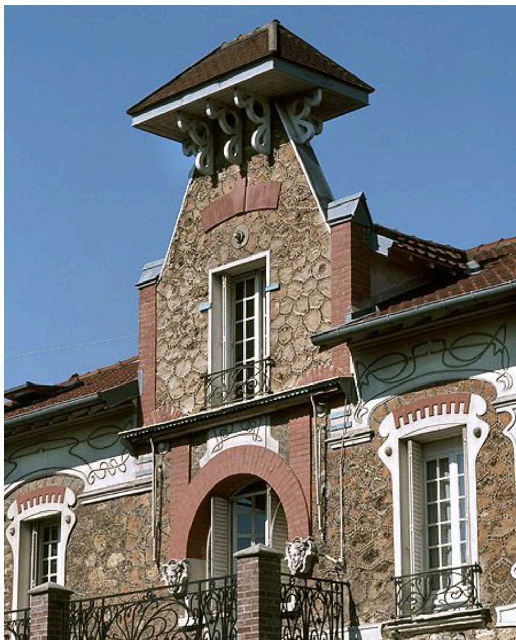
Détail de la lucarne et de son couronnement de la façade principale.
