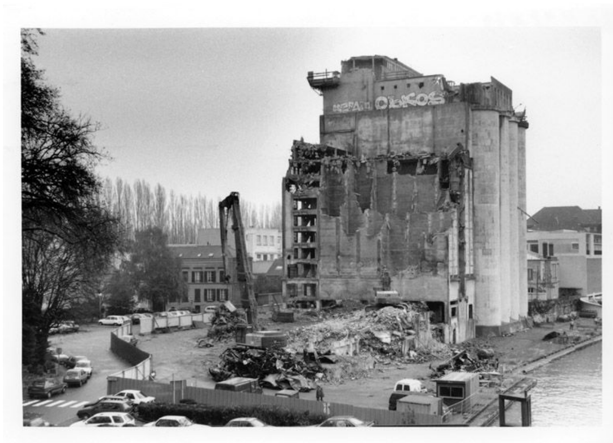
Les silos en cours de démolition. 30 novembre 1998. (Collection particulière)
