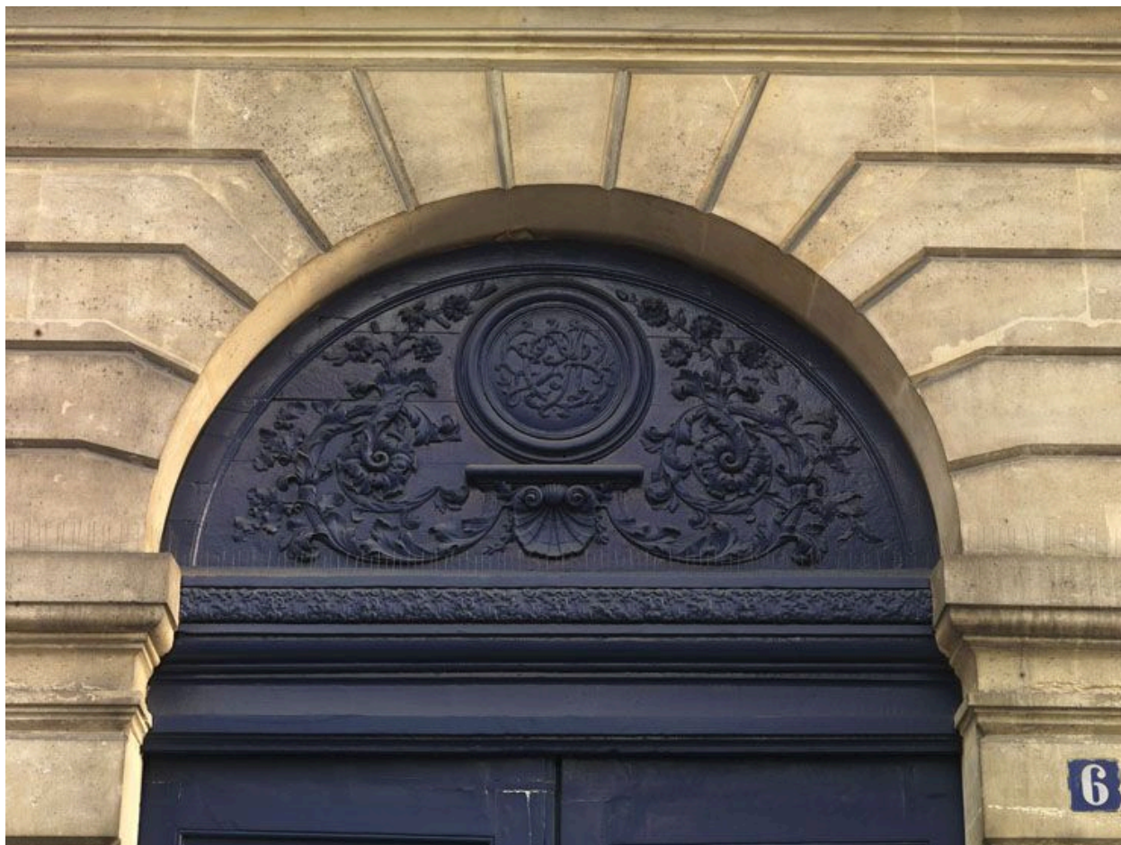
Détail du tympan de menuiserie du portail d'entrée.
