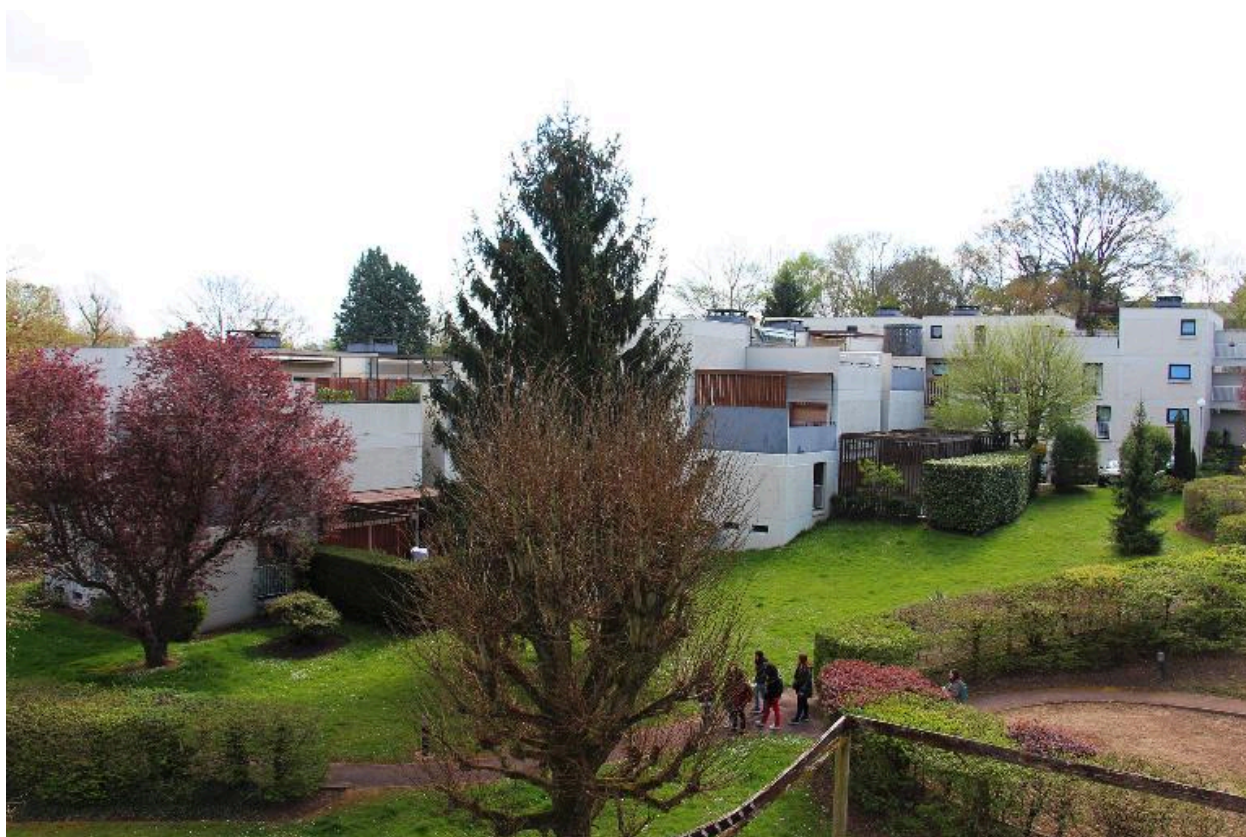
Photographie représentant la volumétrie générale de l'opération de la Nérac.
