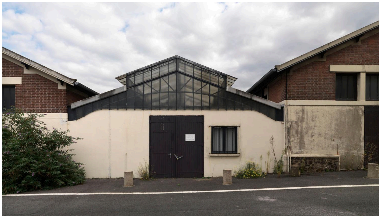
Site Biocitech. Bâtiment éclairé par un lanterneau.
