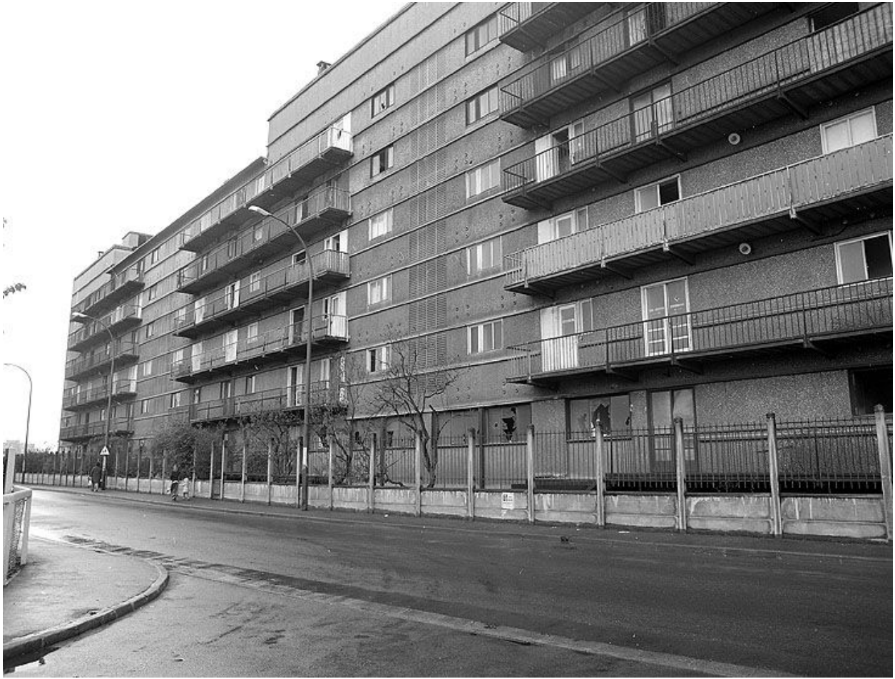
Bâtiment A - Façade nord sur rue Auguste Blanqui. Campagne photographique, lors de la destruction du bâtiment en 1976.
