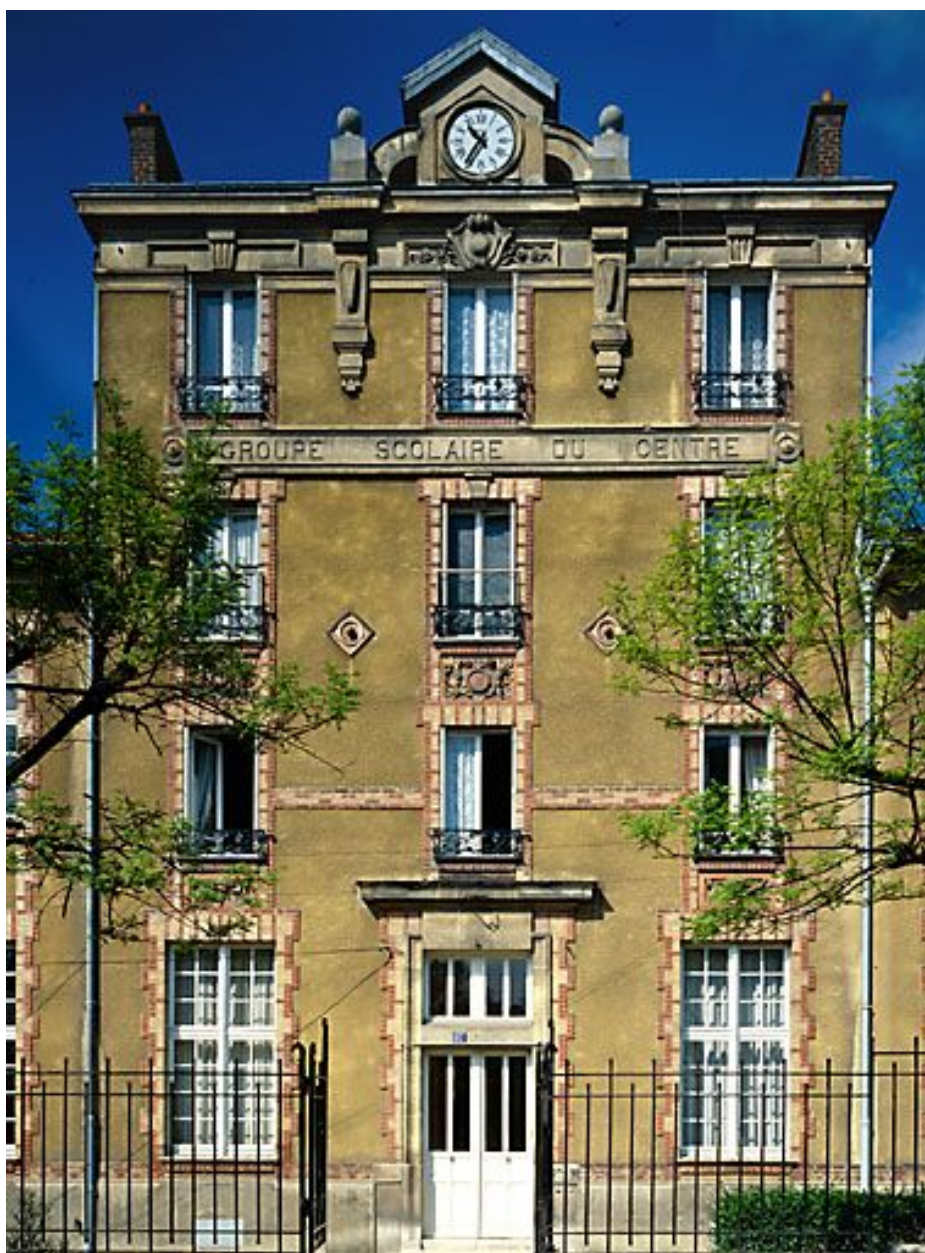
Partie centrale de la façade antérieure.
