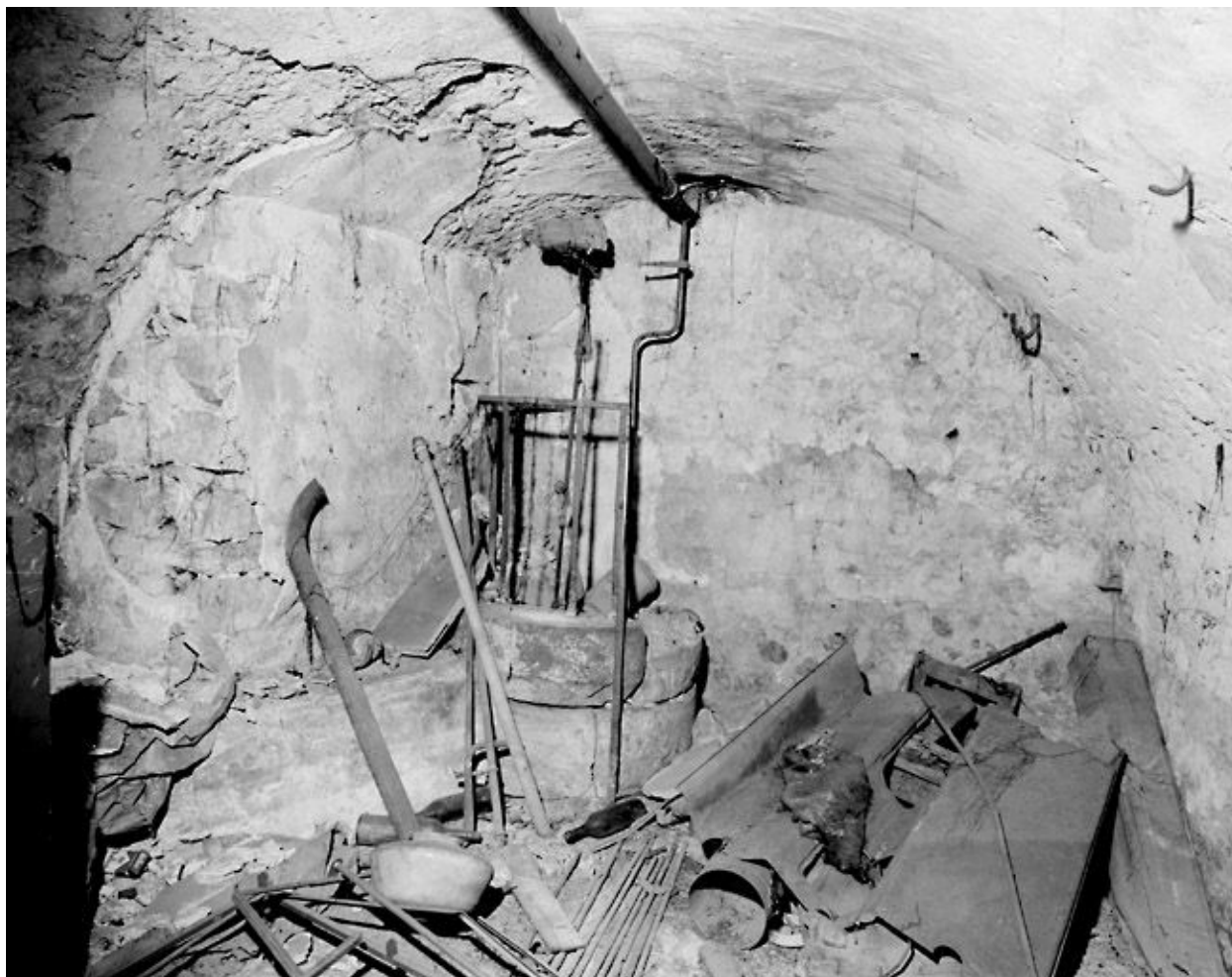
Puits dans la cave.
