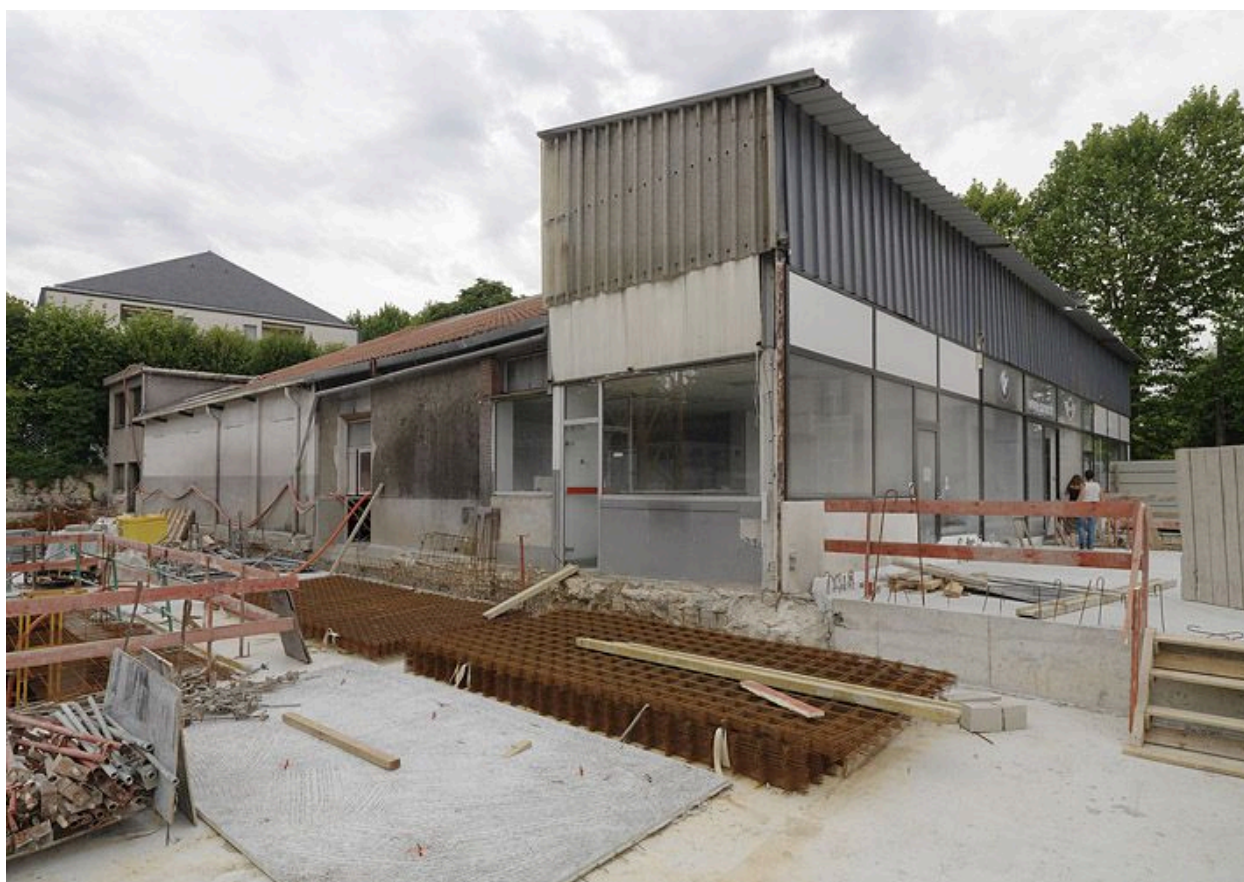
Façade occidentale de la remise de voitures de la Compagnie des Tramways de Fontainebleau, après extensions.
