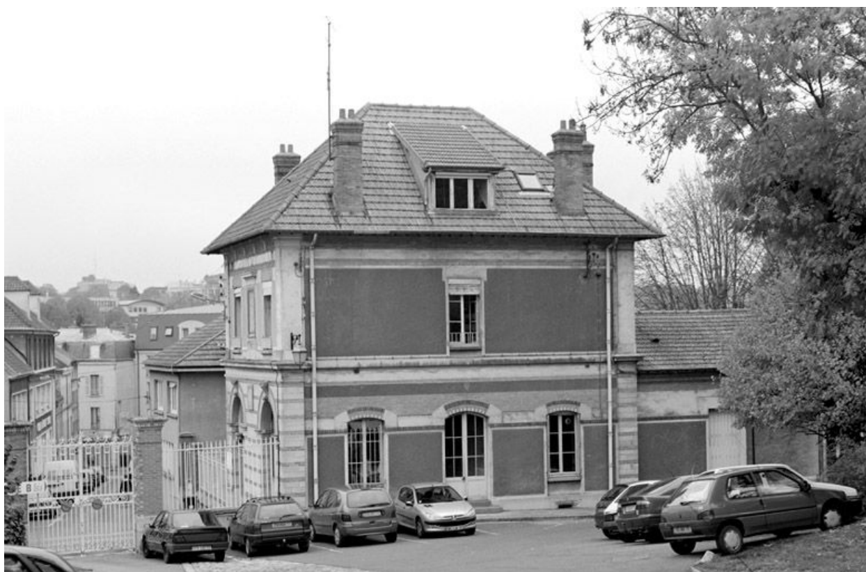
Le pavillon à l'entrée de l'hôpital (9, rue Bontemps) : vue d'ensemble, depuis l'est.
