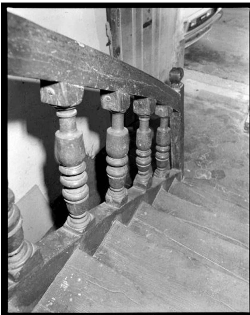
Maison, Tellerie (rue) 3. Vue de l'escalier à rampe à balustres de bois.
