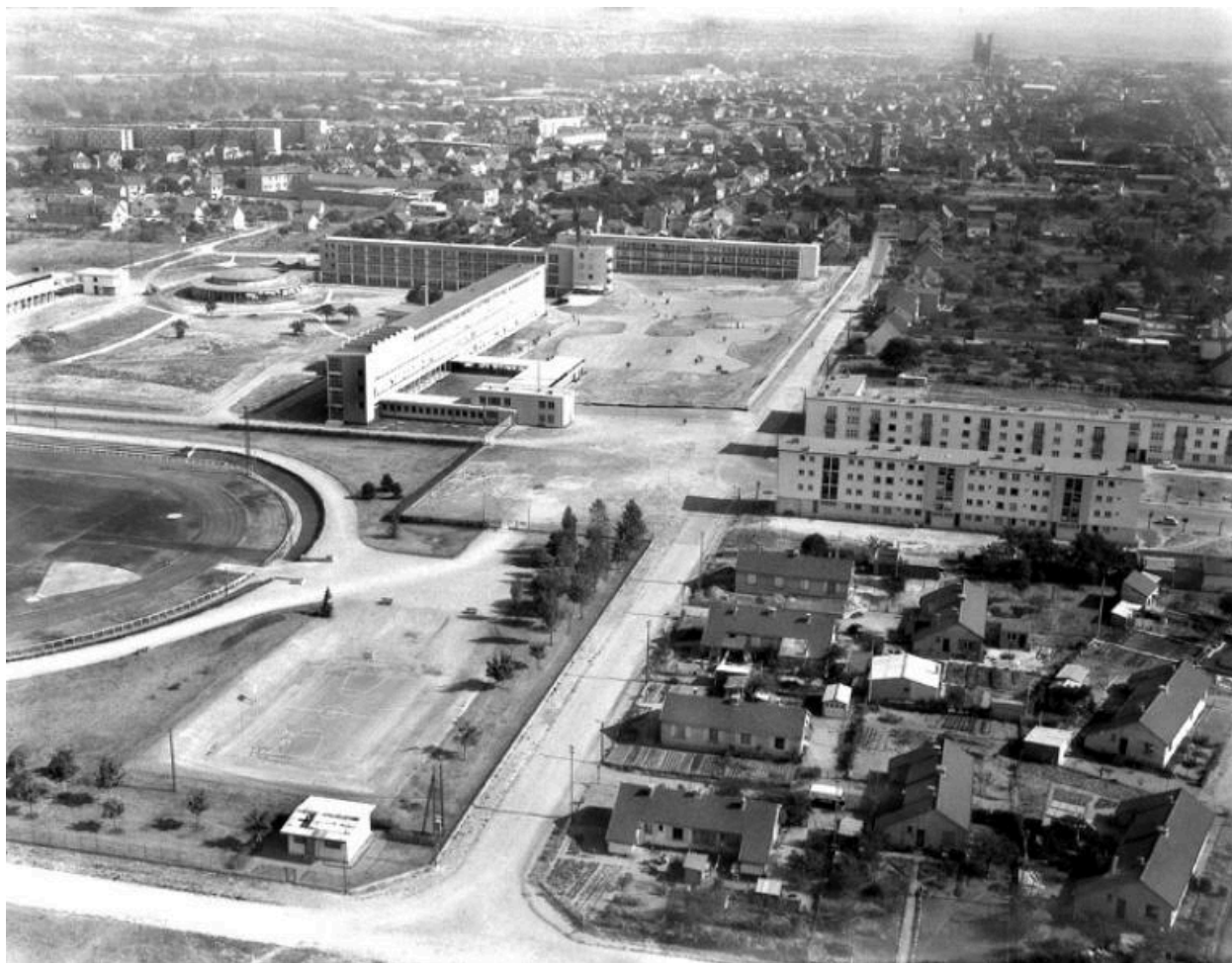
Vue aérienne vers l'ouest des quartiers construits vers 1970. Quartiers 2, 1 3 et 4. (Fonds Bertin).
