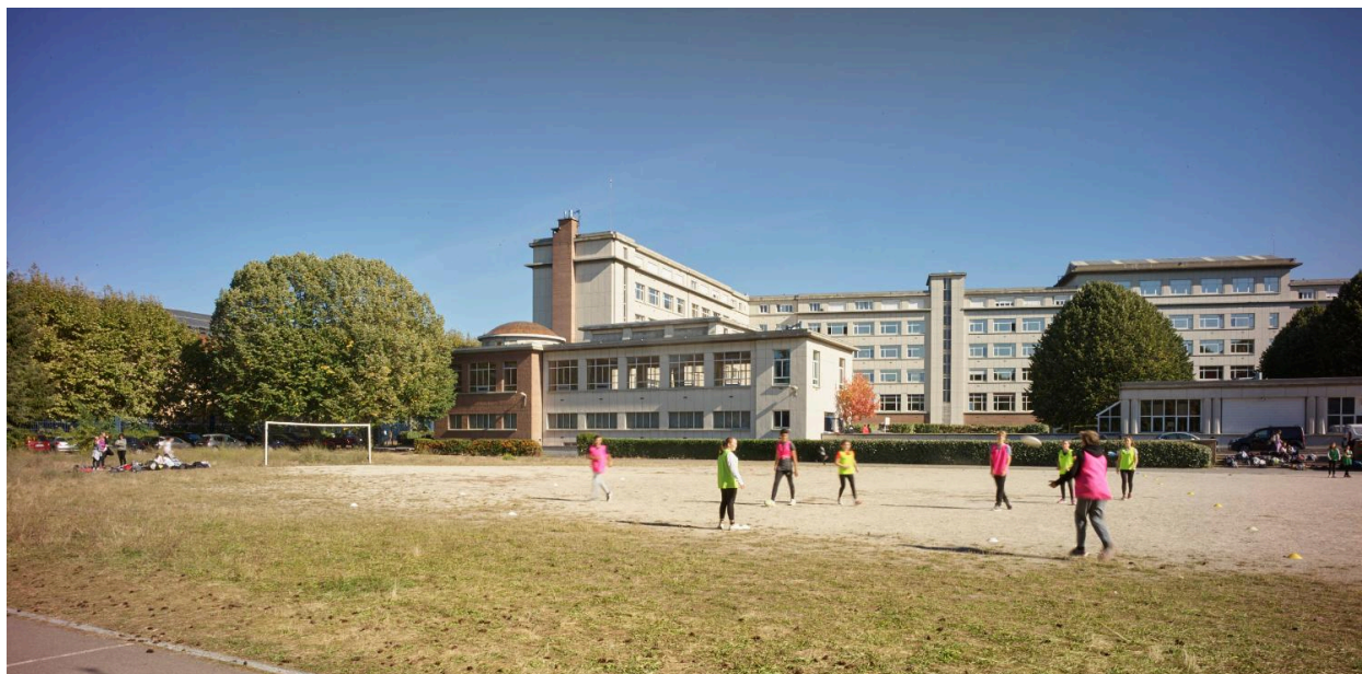
Les terrains de sport, devant l'aile abritant le gymnase surmonté d'une coupole.
