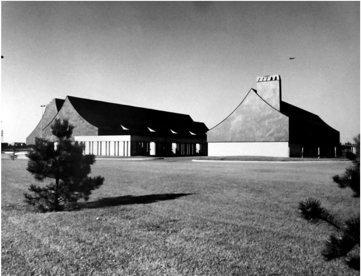
Vue générale de l'aire de service, à gauche le bâtiment des commerces et à droite celui ateliers et hangars. Photographie NB, [1973].
