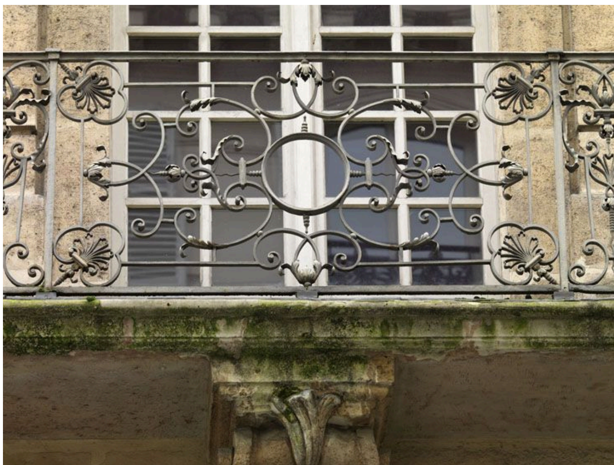
Détail du garde-corps du balcon.
