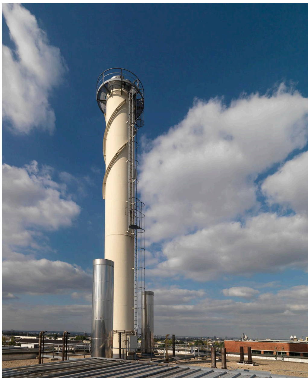
Site Sanofi. Vue de la cheminée, toit du bâtiment de la chaufferie.
