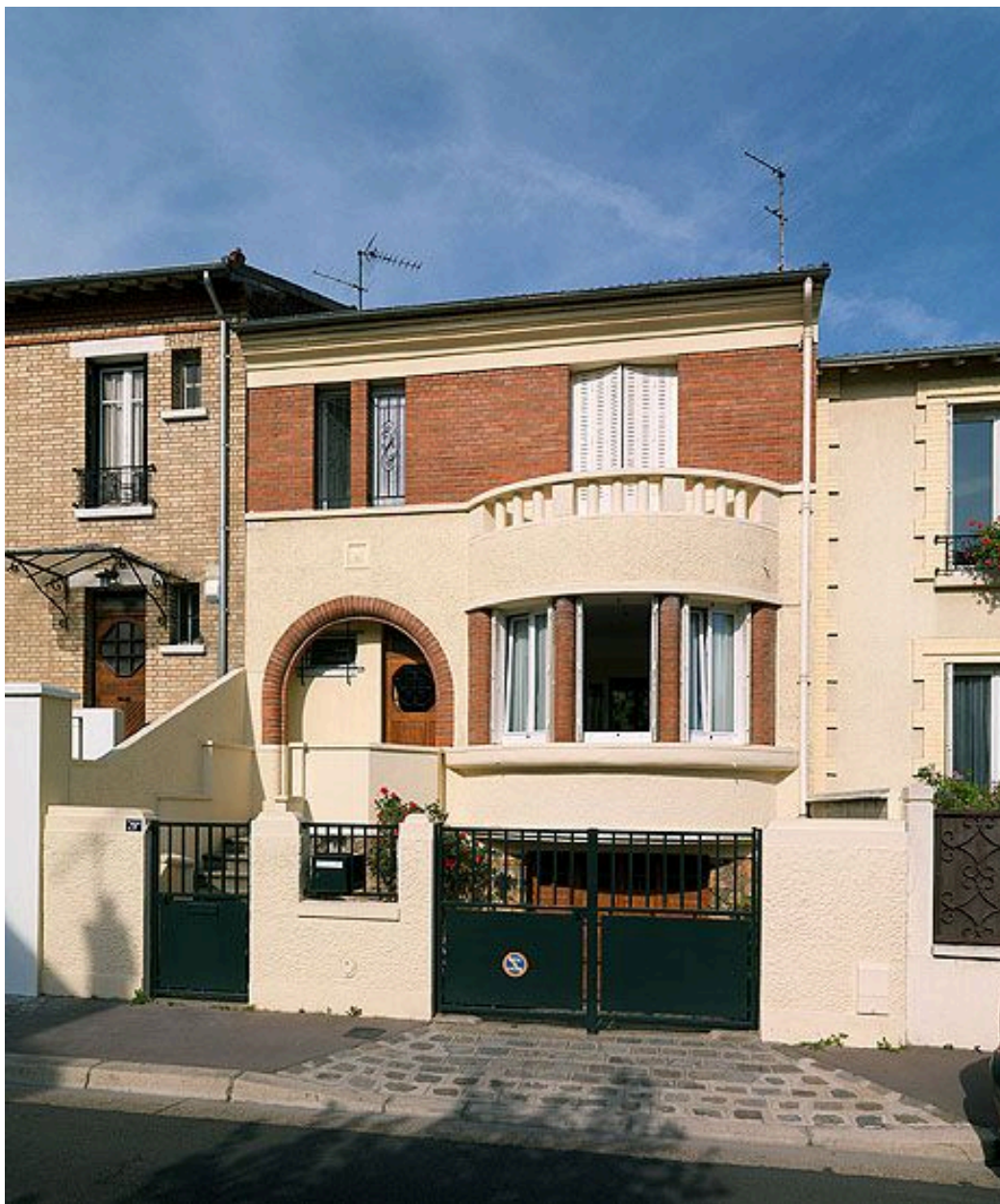
92, Colombes, maison, Théodule Ribot (rue) 29bis. Façade antérieure sur la rue.
