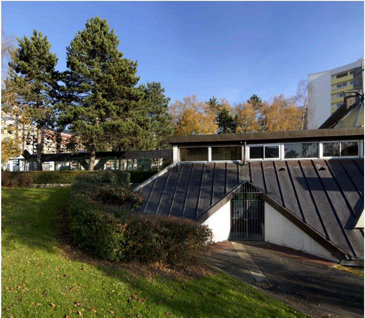
Vue de l'entrée au niveau inférieur.
