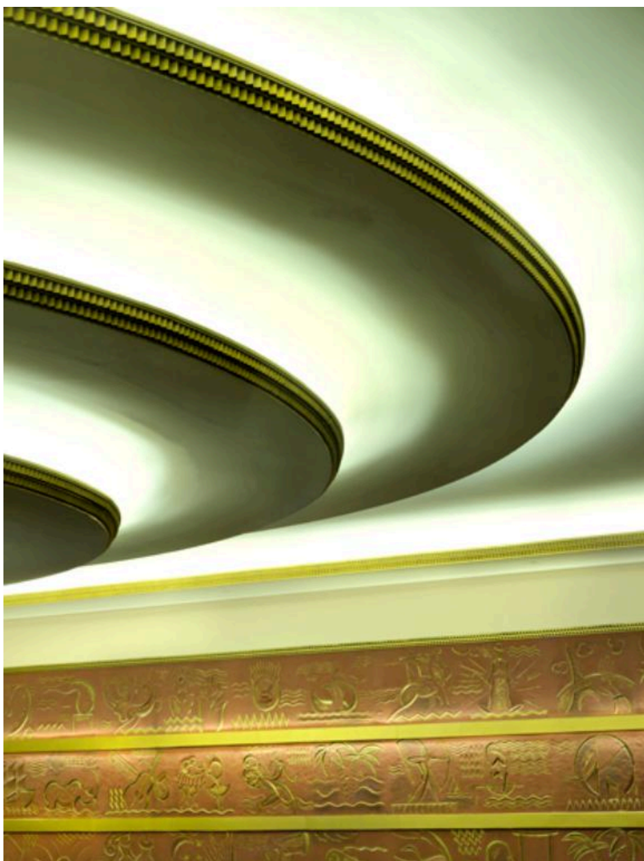
Détail, plafond, frises de denticules triangulaires, éclairage indirect
