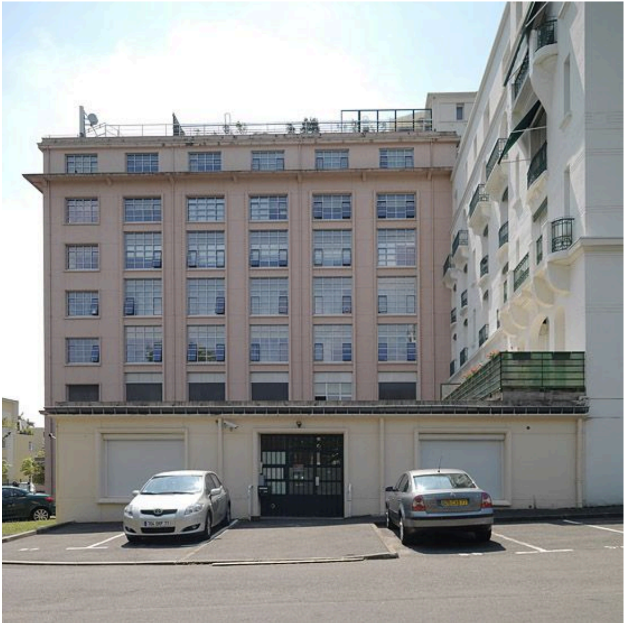
Façade sud-est de l'extension PIC.
