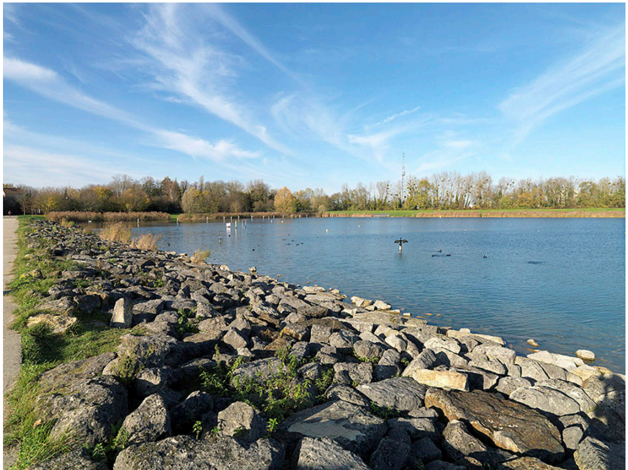
Le déversoir du lac de Vaires.
