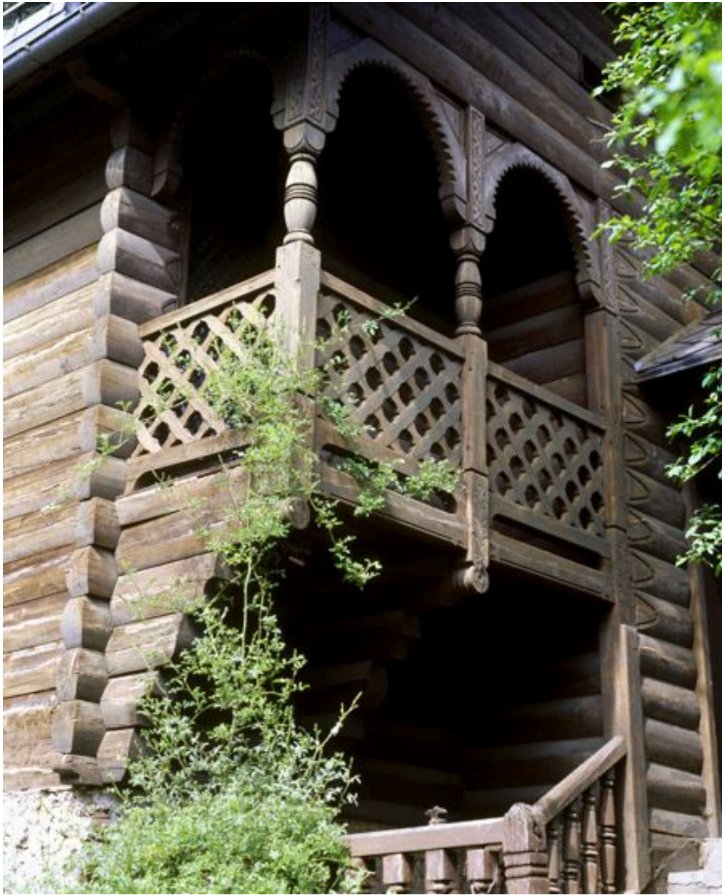
Pavillon d'exposition scandinave, 23 avenue Martelet. Détail du balcon du pavillon scandinave provenant de l'exposition universelle de 1889 remonté dans le parc de la villa. Garnier, Charles (architecte)
