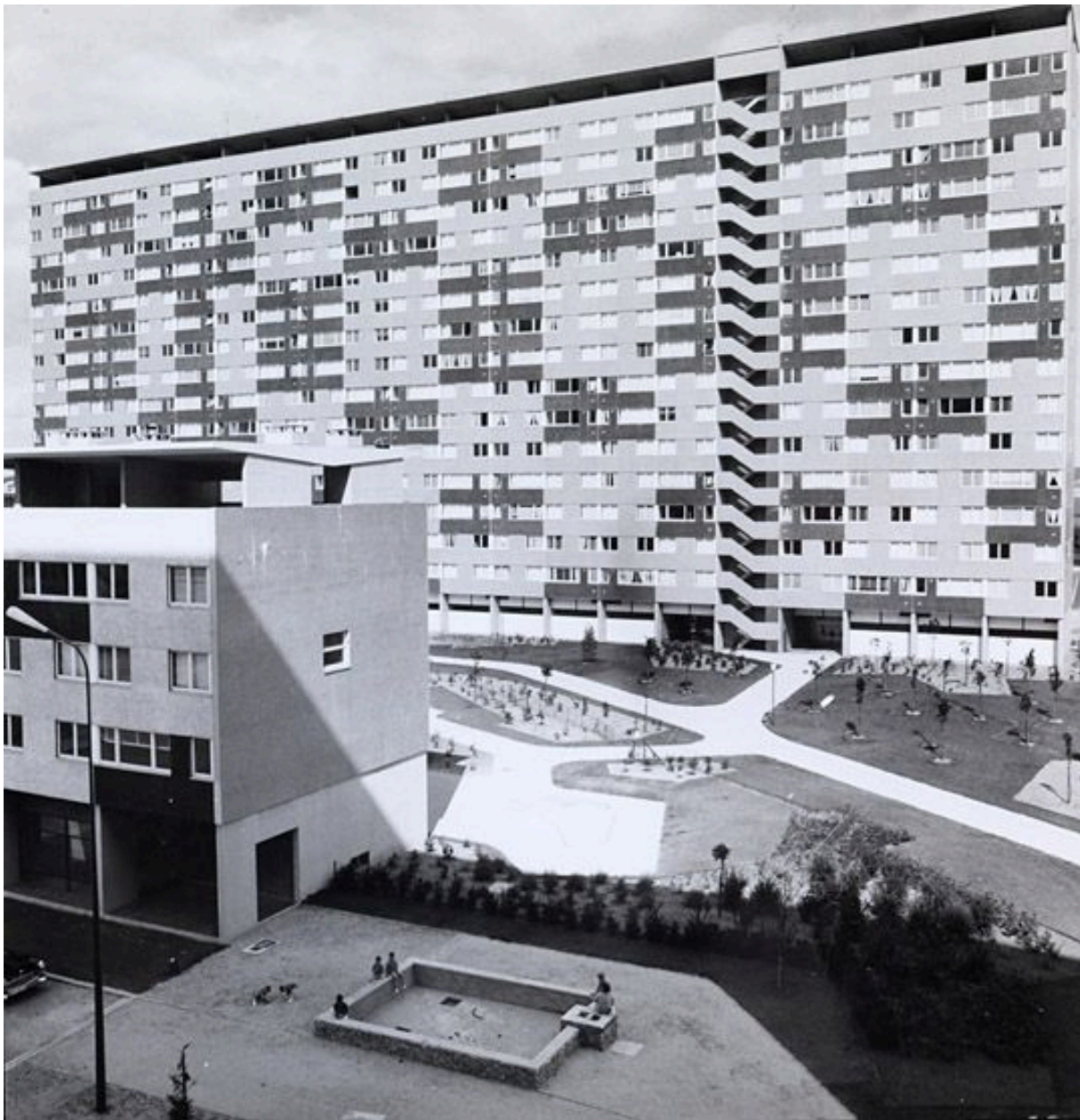
Barres de la Pierre-Collinet. Vue du prototype avec les séchoirs en haut. (Cité de l'architecture et du patrimoine. fonds Ginsberg 100 boîte 3006)
