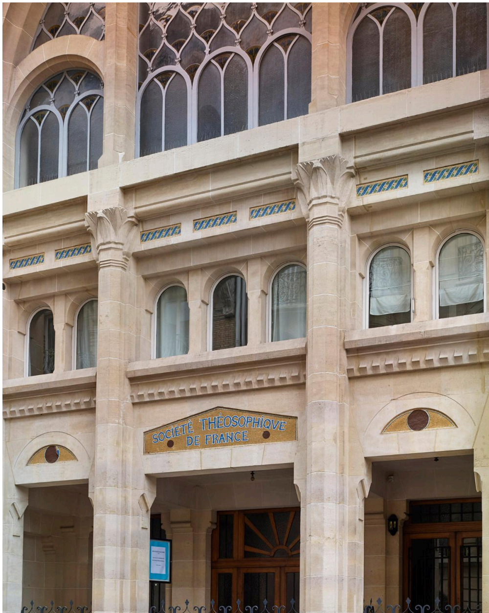
Façade, détail de l'entrée-porche de la Société théosophique, portique
