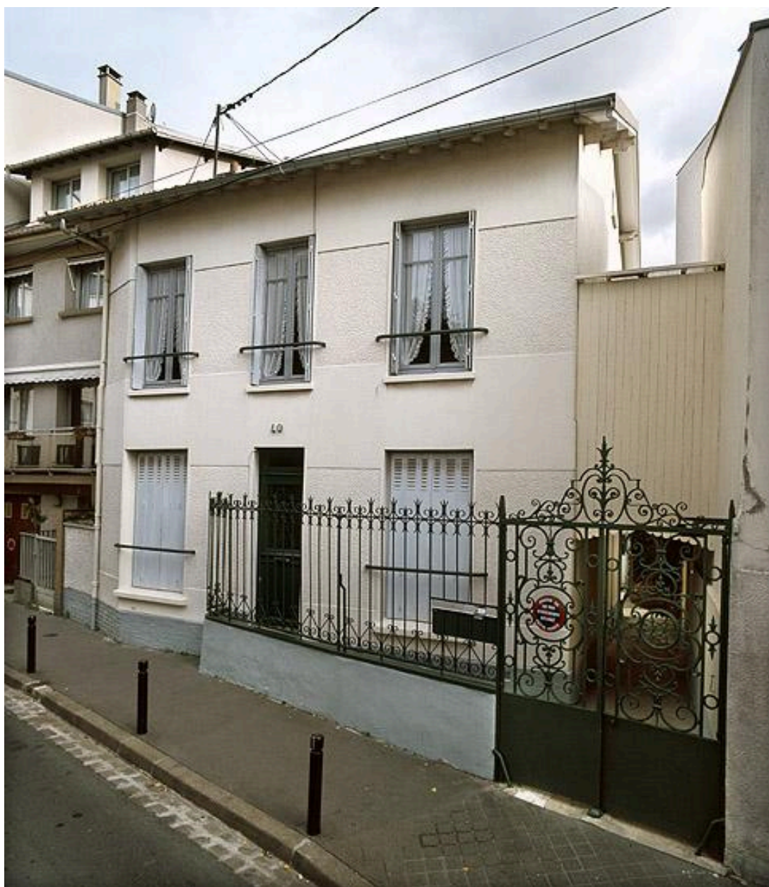
Maison d'habitation et grille en fer forgé, oeuvre du fils du serrurier BreLOT.
