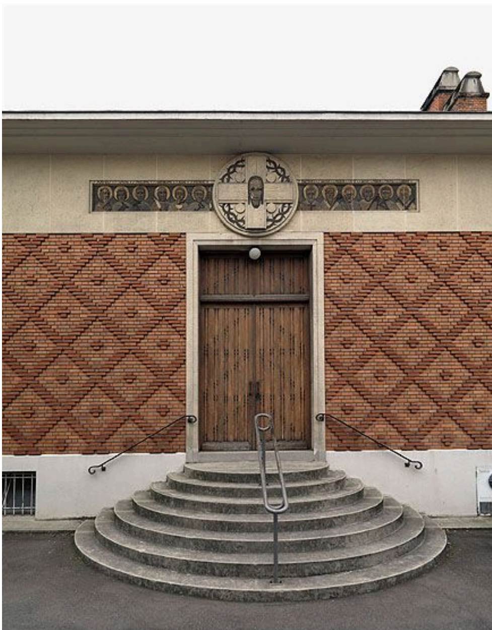
92, Boulogne-Billancourt, église paroissiale Sainte-Thérèse, 62 rue del' Ancienne-mairie Appreil de façade du flanc nord de l'église.
