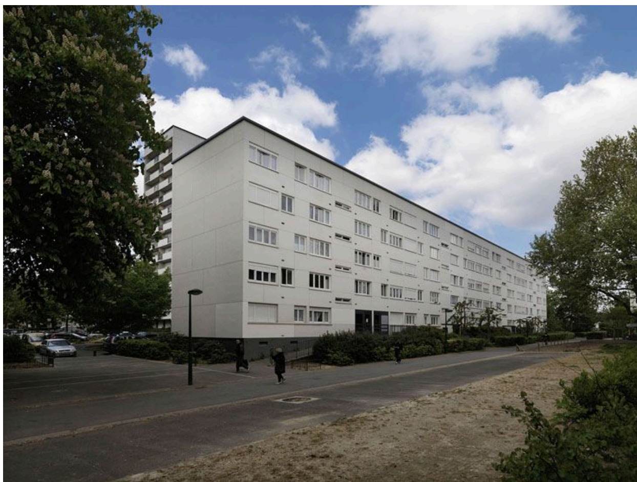
La barre C réhabilitée.
