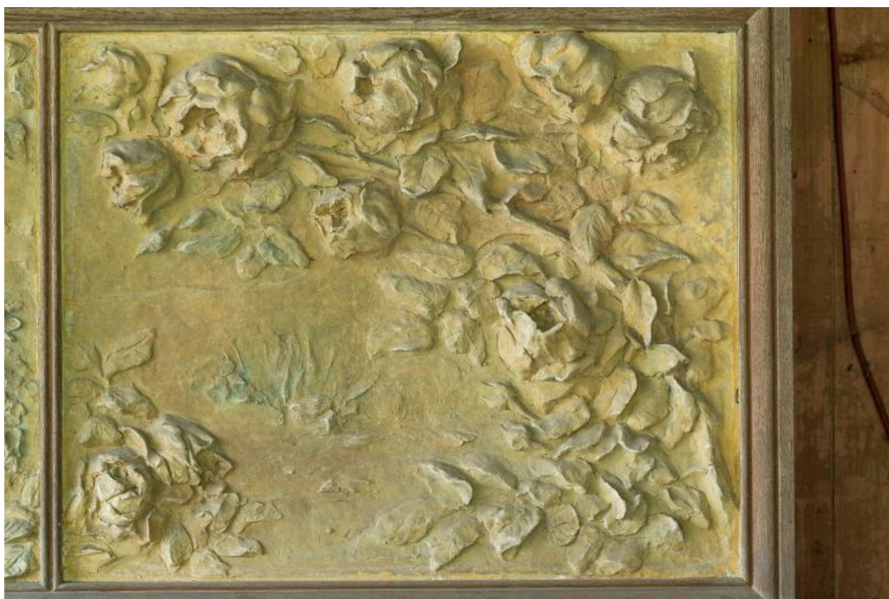
Détail du linteau (2)
