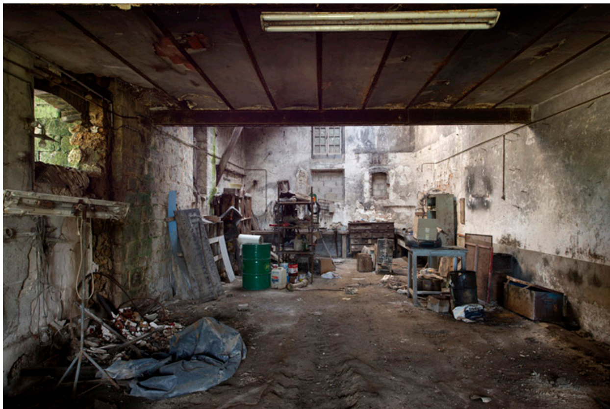
Vue d'ensemble de l'intérieur de l'annexe de l'angle nord est.
