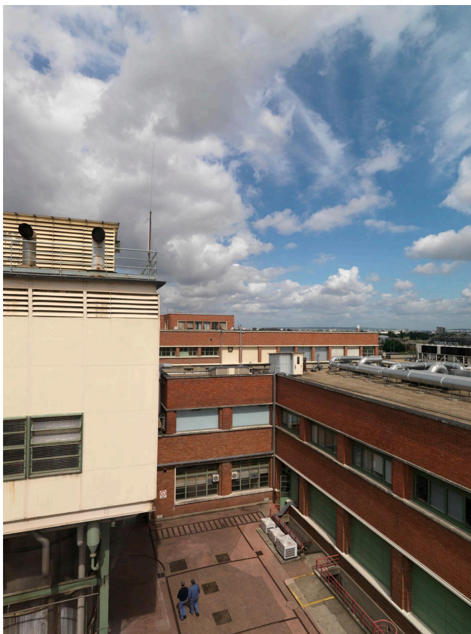
Site Sanofi. Vue depuis les toits.
